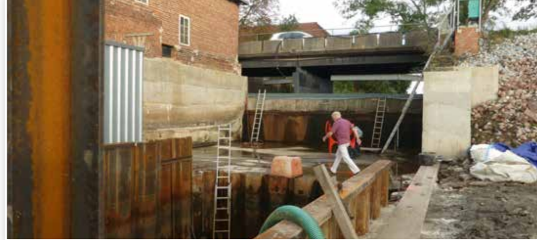
Hier wird zukünftig die Wasserschnecke ihren Dienst tun.
